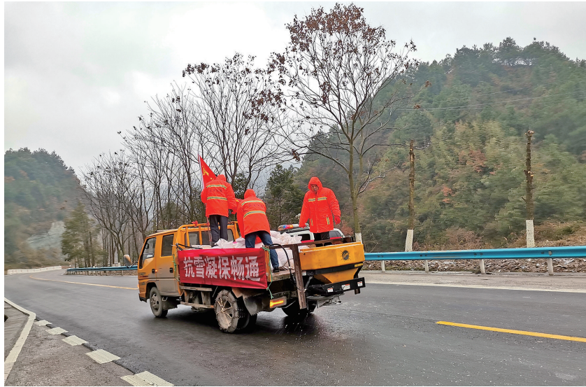
工作人员在G243线黄平重点路段进行撒环保融雪剂除冰作业
