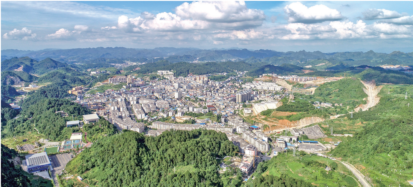
建设中的麻江县城 (通讯员 张旭东 摄)
