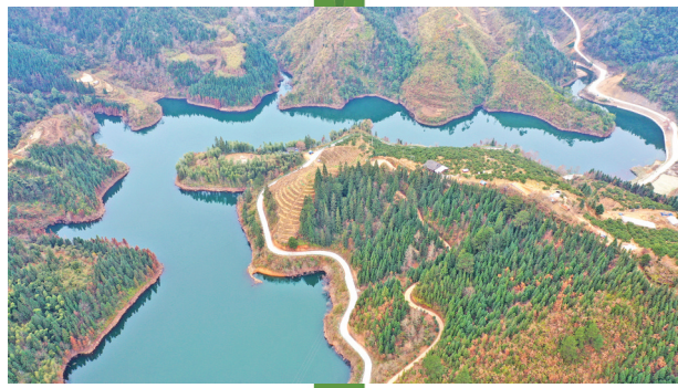
榕江县古州镇 归九溪人饮水库
