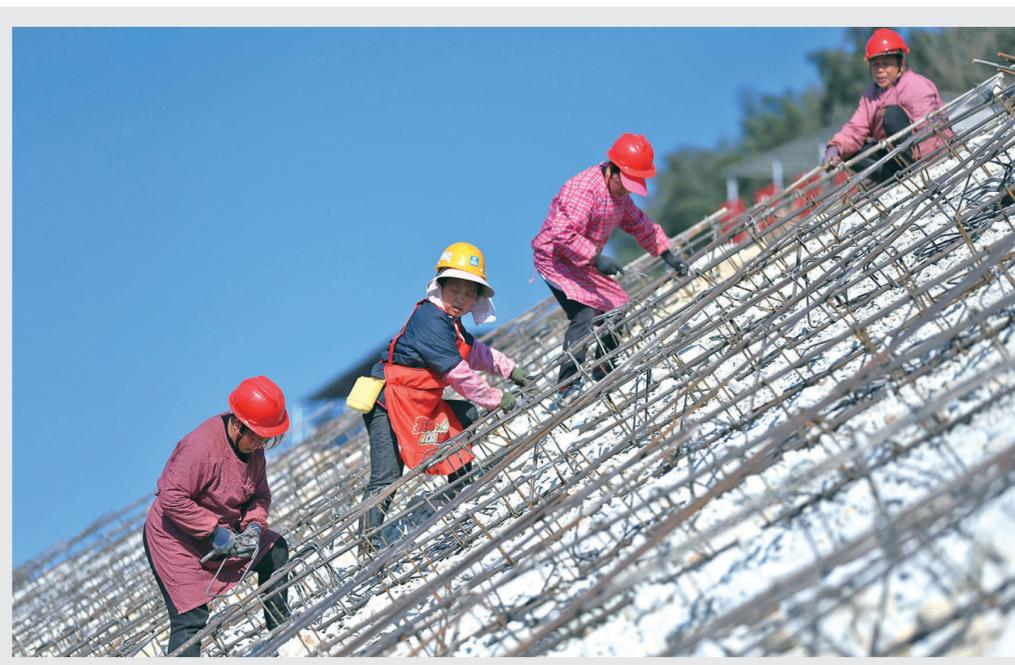
时下,在锦屏县三江镇潘寨村的清水江河段治理施工现场,施工人员忙着开展搅拌、浇注、焊接等作业,确保早日完成各项工程建设任务。该河段治理总长2.71千米,将对原河堤堤身边坡及堤顶进行修整、绿化、铺设人行步道,建成集防洪、休闲、景观功能于一体生态防洪堤。
