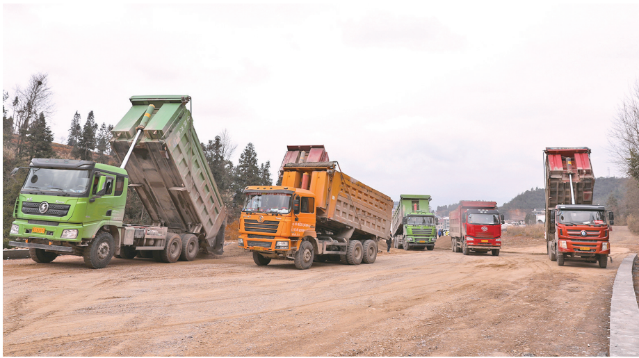
图为牛大场镇道路升级改造工程现场 (通讯员 杨静 摄)
