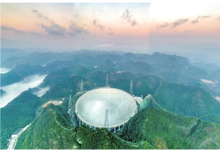
这是2020年1月9日拍摄的“中国天眼”（检修期间拍摄）。
