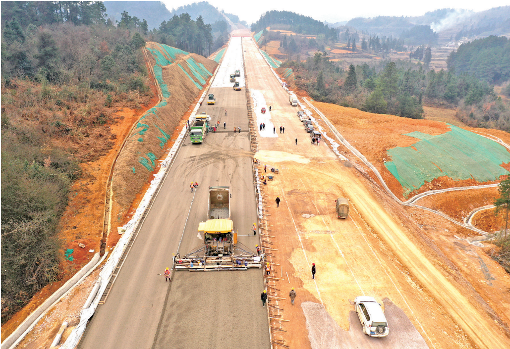
图为贵黄高速公路路面摊铺施工现场
