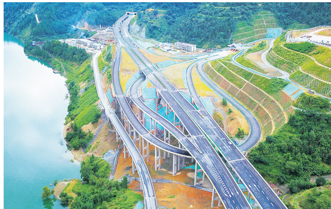
剑榕高速柳川互通航拍图（新华社记者 杨文斌 摄）
