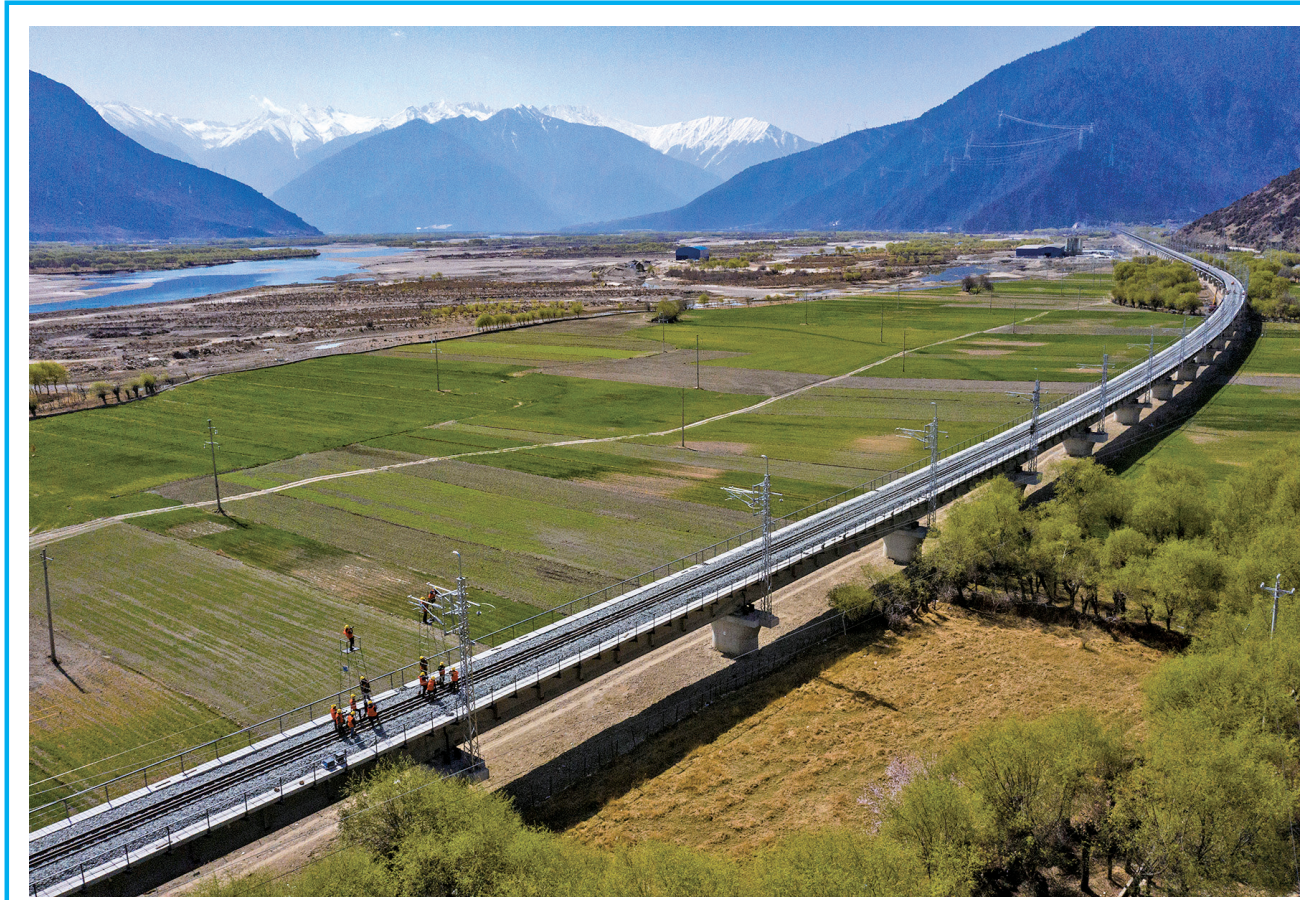
据中国铁路青藏集团有限公司介绍，目前拉萨至林芝铁路新建的桥梁、隧道、路基铺架主体工程已全部完成，具备静态验收条件，4月1日起至4月30日，拉萨至林芝铁路进入静态验收阶段。拉林铁路是国家“十三五”规划重点工程项目，全长435公里，设计时速160公里，是西藏首条电气化铁路。 图为3月28日，中铁电气化局集团技术人员在拉林铁路进行接触网精调作业。 (新华社发 焦宏涛 摄)
