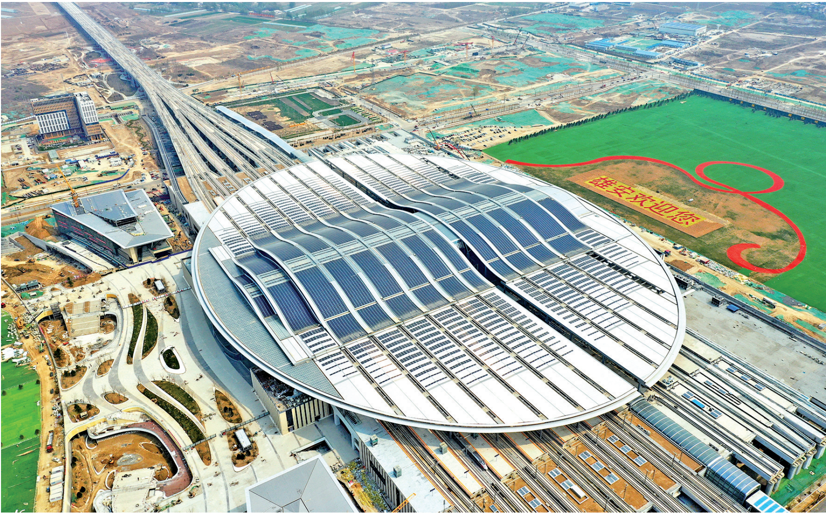
图为4月9日拍摄的京雄城际铁路雄安站(无人机照片)。(新华社记者 牟宇 摄)
