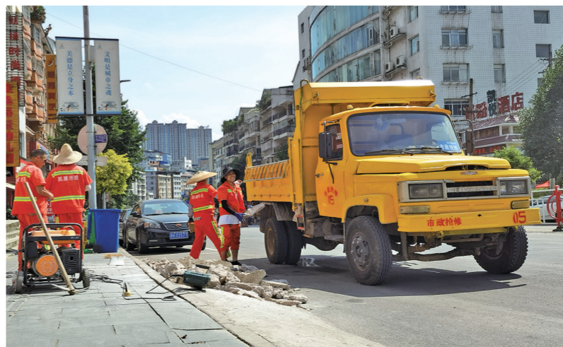
市政工人在清理路面
