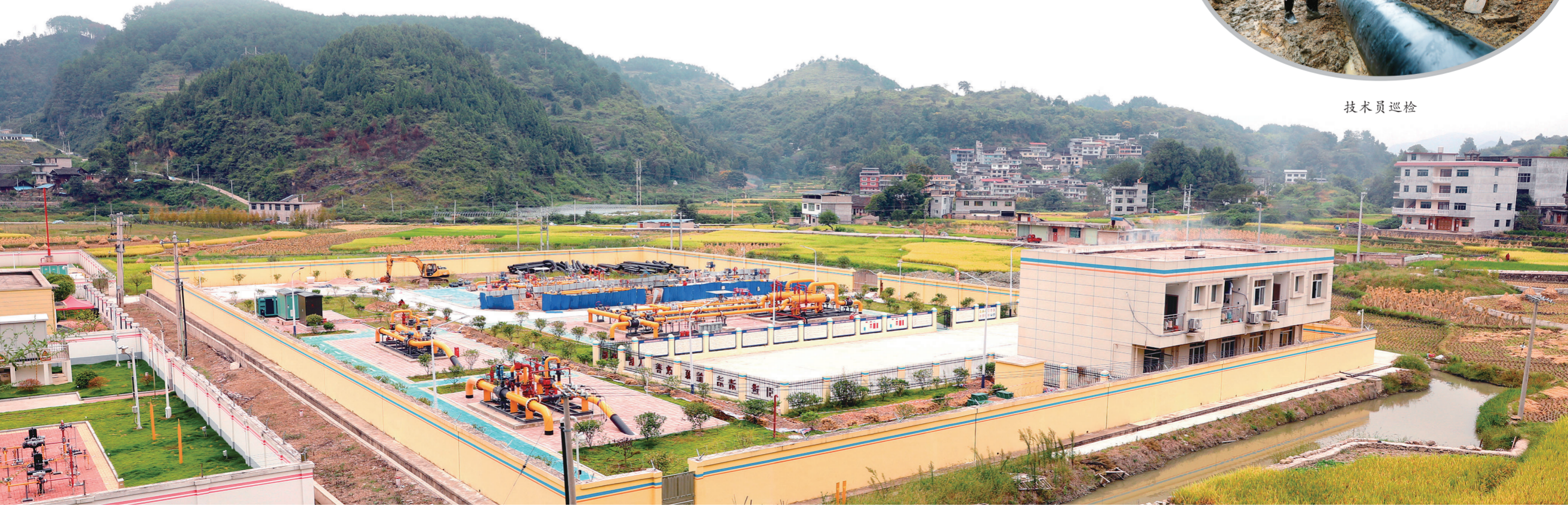
凯里输气站全景
