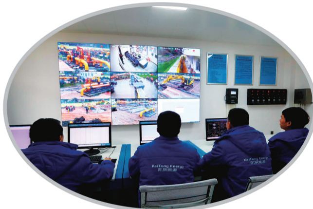
输气站总监控室一角
