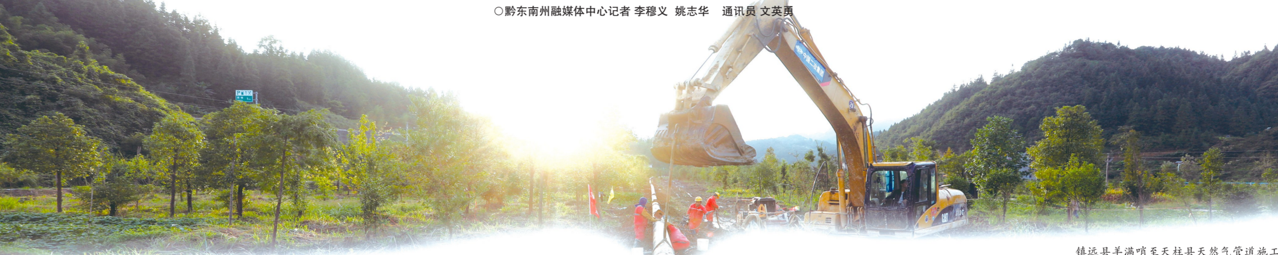
镇远县羊满哨至天柱县天然气管道施工
