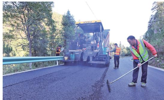
11月8日，在榕江县乐里至寨蒿公路寨蒿段，施工人员进行摊铺沥青混凝土面层。施工人员抢抓晴朗天气施工，确保群众安全出行。（通讯员 李长华 摄）
