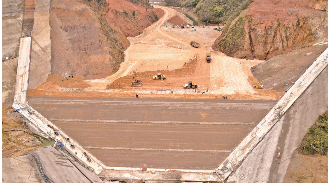
图为白头旺水库工程复工后建设场景(通讯员 田洪毅 摄)
