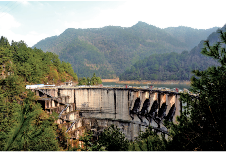
里禾水库大坝
