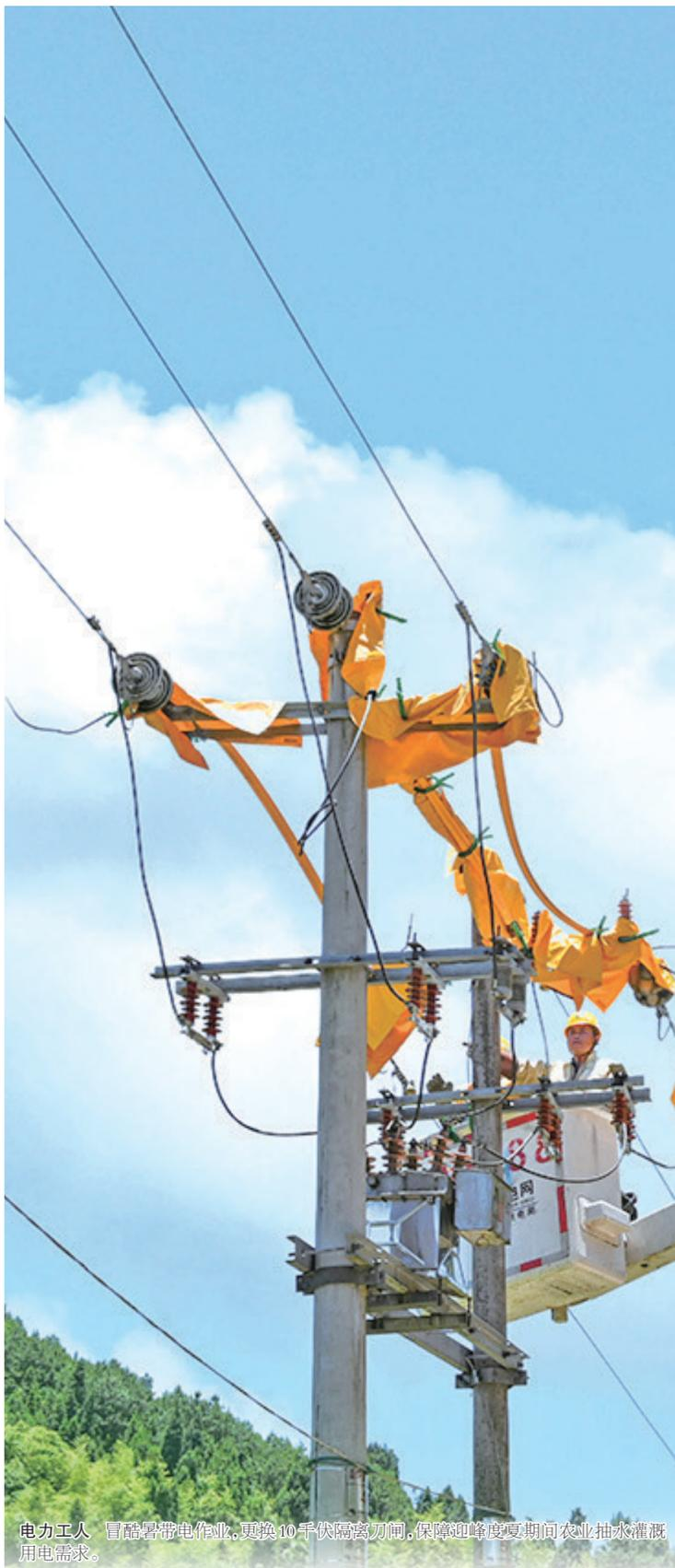
电力工人 冒酷暑带电作业,更换10千伏隔离刀闸,保障迎峰度夏期间农业抽水灌溉用电需求。
