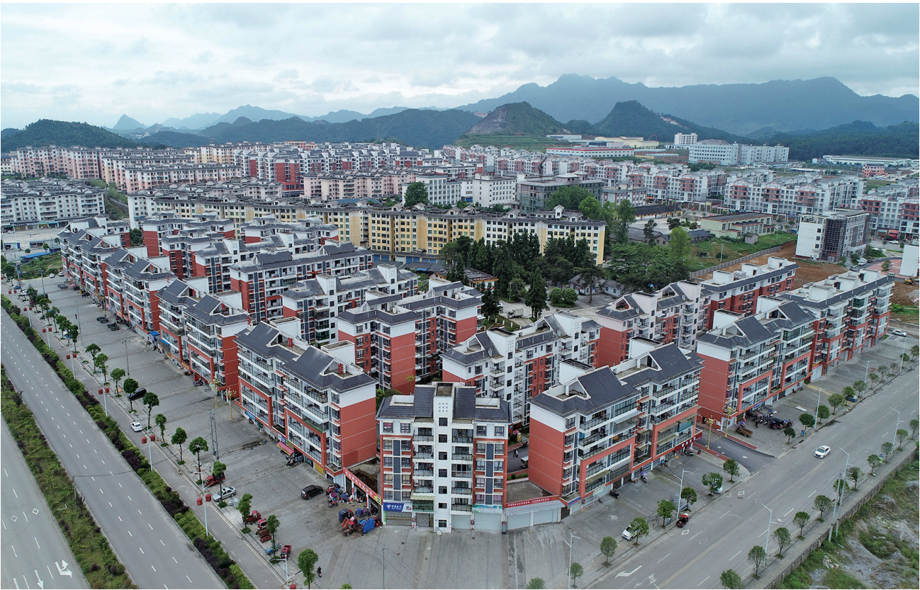
图为丹寨县金泉街道移民安置区
