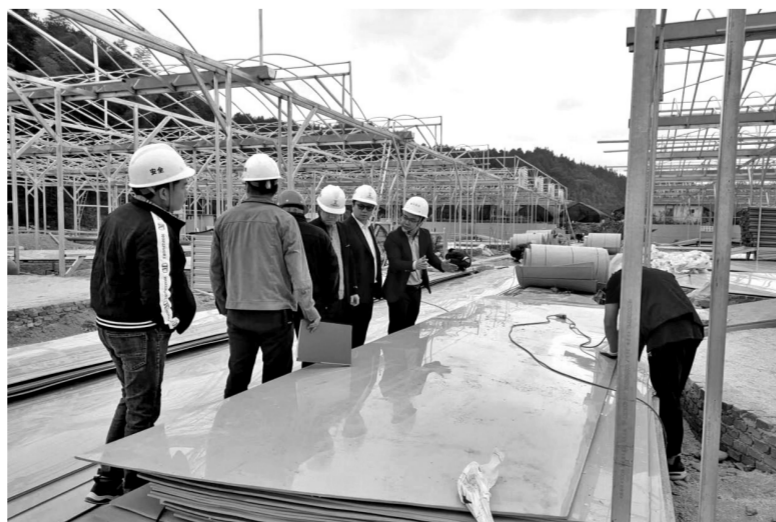
检查施工情况(通讯员 杨国辉 摄)
