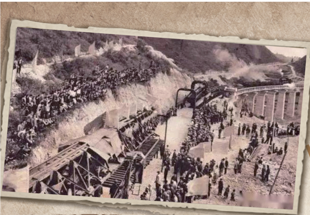
当年正在建设中的湘黔铁路
