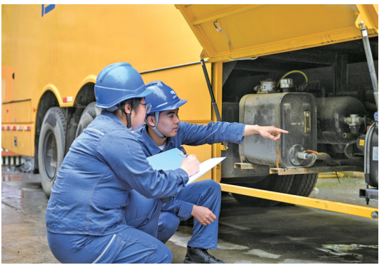
图为供电工作人员在对发电车供油系统进行检查
