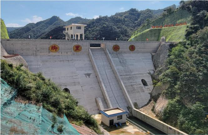
凯里市脚里水库工程位于旁海镇猴子寨,主要任务是以凯里市旁海镇集镇供水、农村人畜供水及水库下游农田灌溉用水为供水任务的综合利用水库工程,供水人口24900人,灌溉面积1570亩。坝顶高程为791.00m,最大坝高41.0m,坝顶长79米,坝顶宽5米,正常蓄水位为788.00m,总库容147万m<sup>3</sup>,兴利库容111.88万m<sup>3</sup>。泄水建筑物为开放式溢洪道,堰顶高程788米,溢流净宽8米。输水建筑物为输水管道,管道总长19.967km。工程规模为IV等小(1)型工程。工程总投资为18717万元,工程总工期为24个月。目前水坝已经建成。
