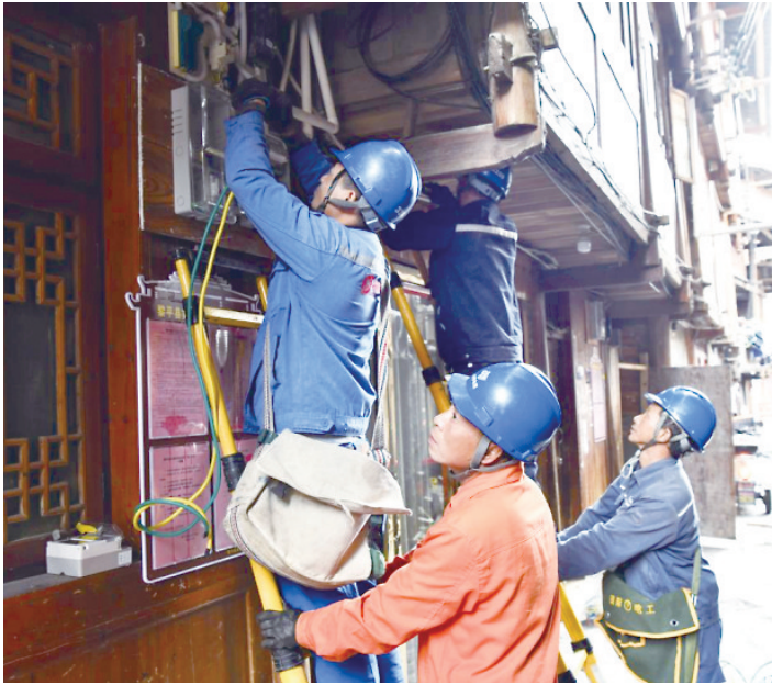
迁移电表并安装阻燃板
