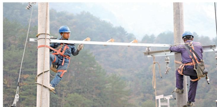
图为施秉供电局施工人员在架设导线
