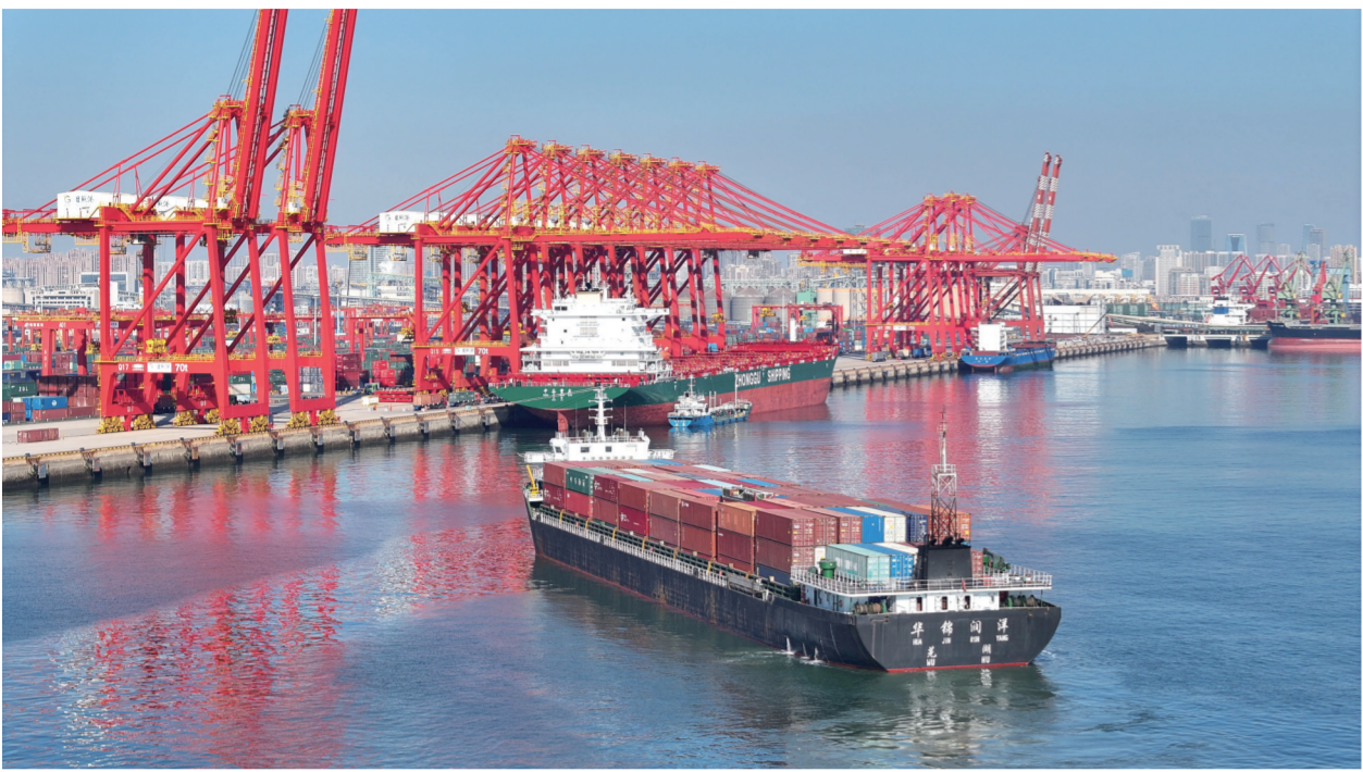
在山东港口日照港,货轮停泊集装箱码头装卸作业(2024年1月10日摄)。(新华社记者 郭绪雷 摄)
