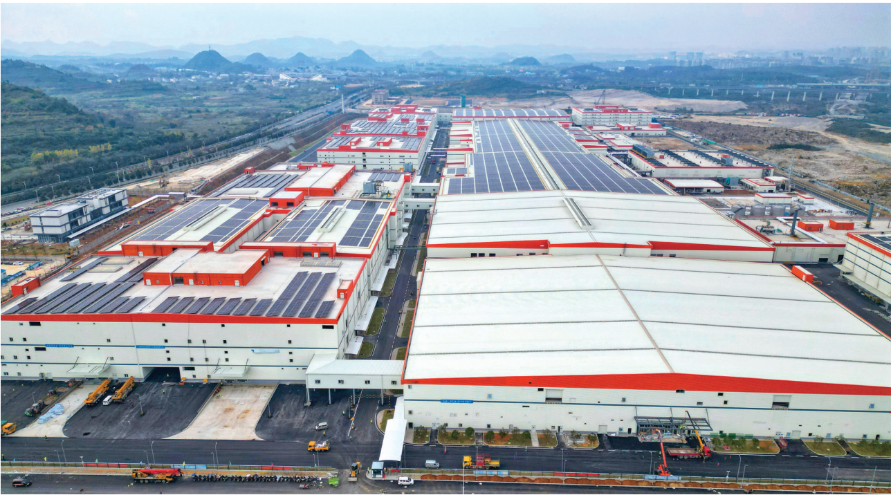
图为宁德时代(贵州)新能源动力及储能电池生产制造基地。(新华社记者 向杰杰 摄)
