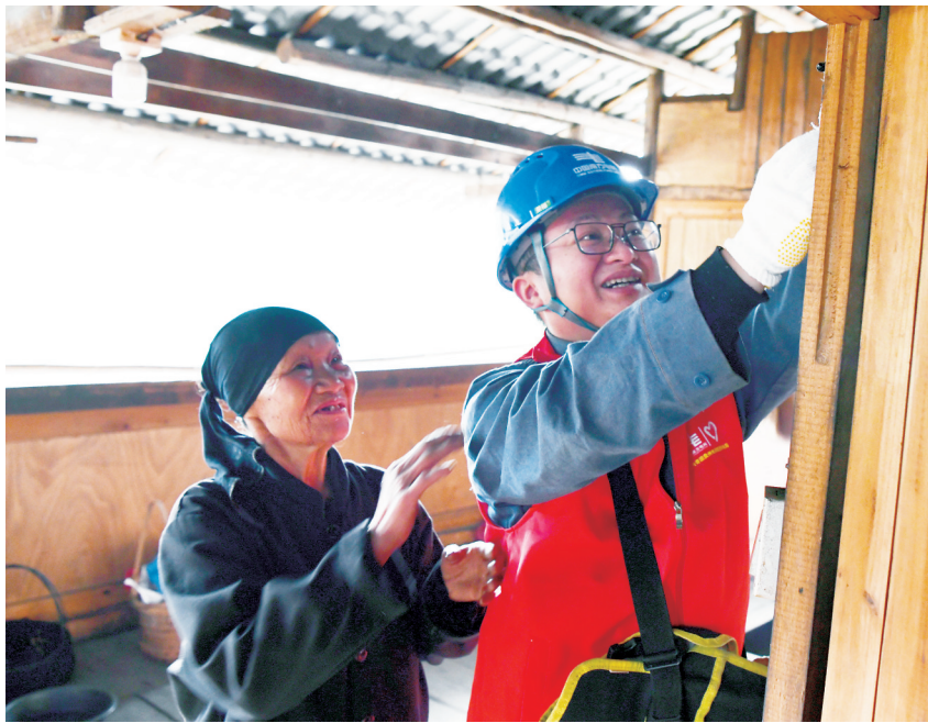
为老人检查室内线路
