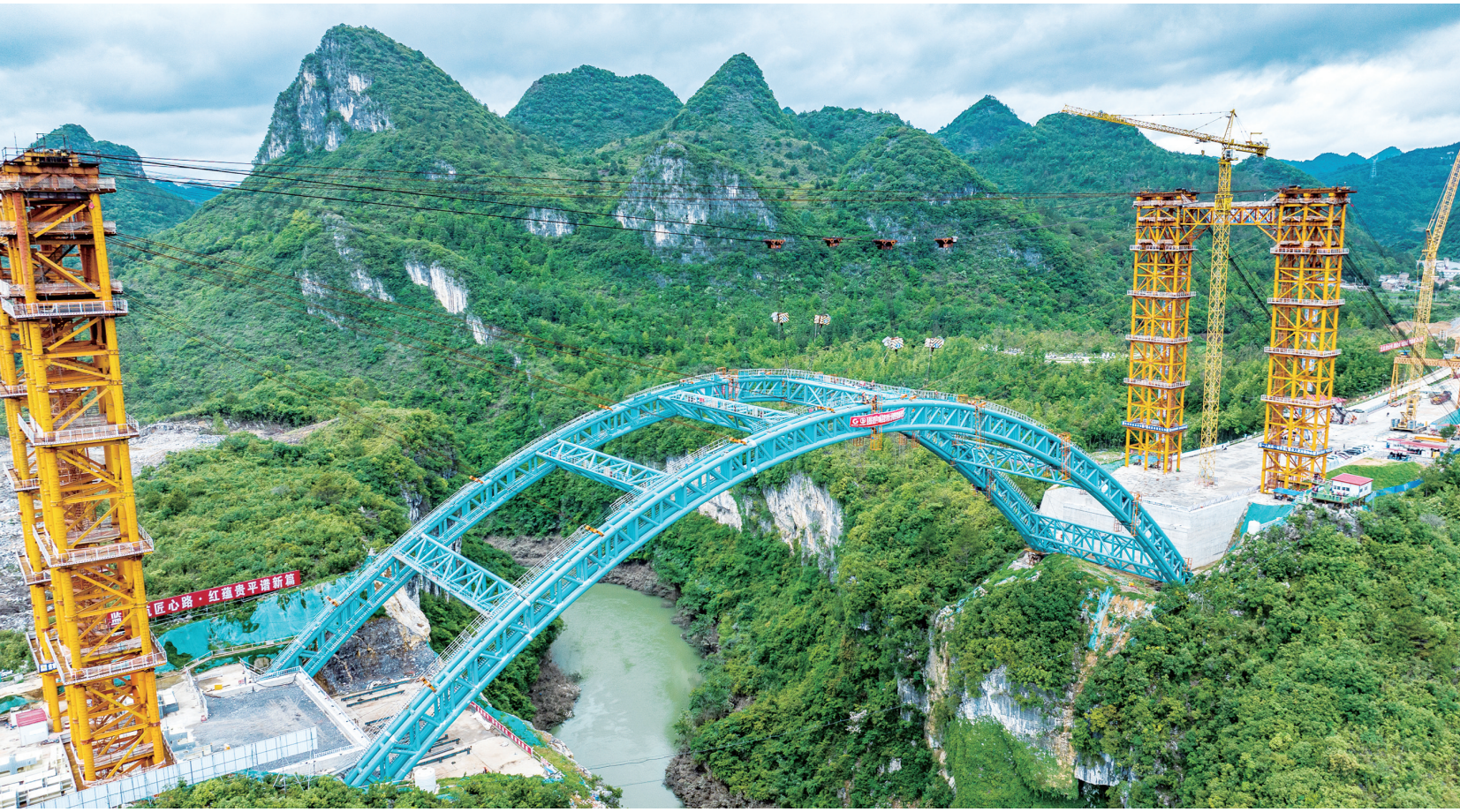
拉密河特大桥 钢管拱肋顺利合龙
