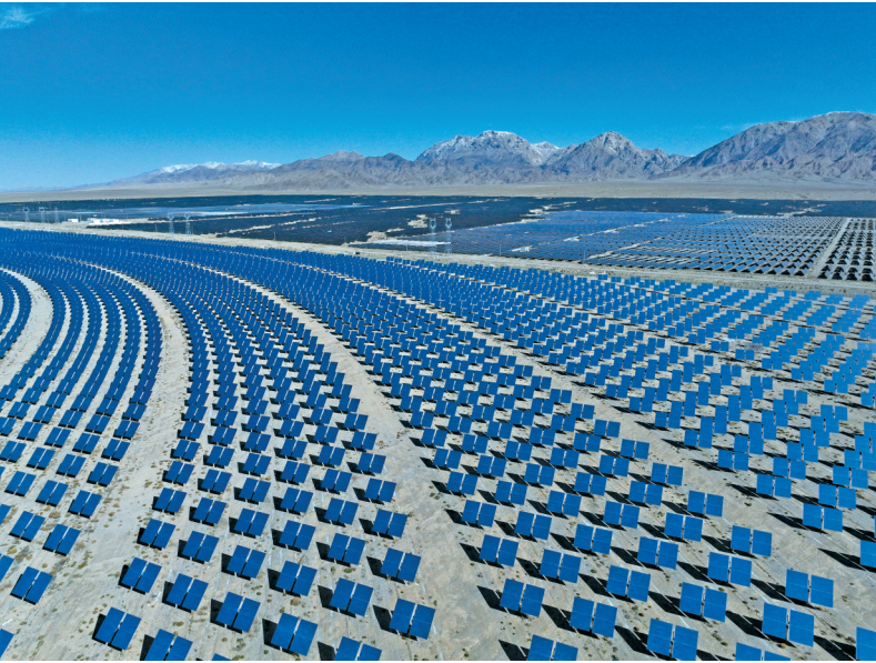
图为2024年4月23日在青海省海西蒙古族藏族自治州德令哈市光伏(光热)产业园拍摄的光热电站。(新华社记者 张龙 摄)
