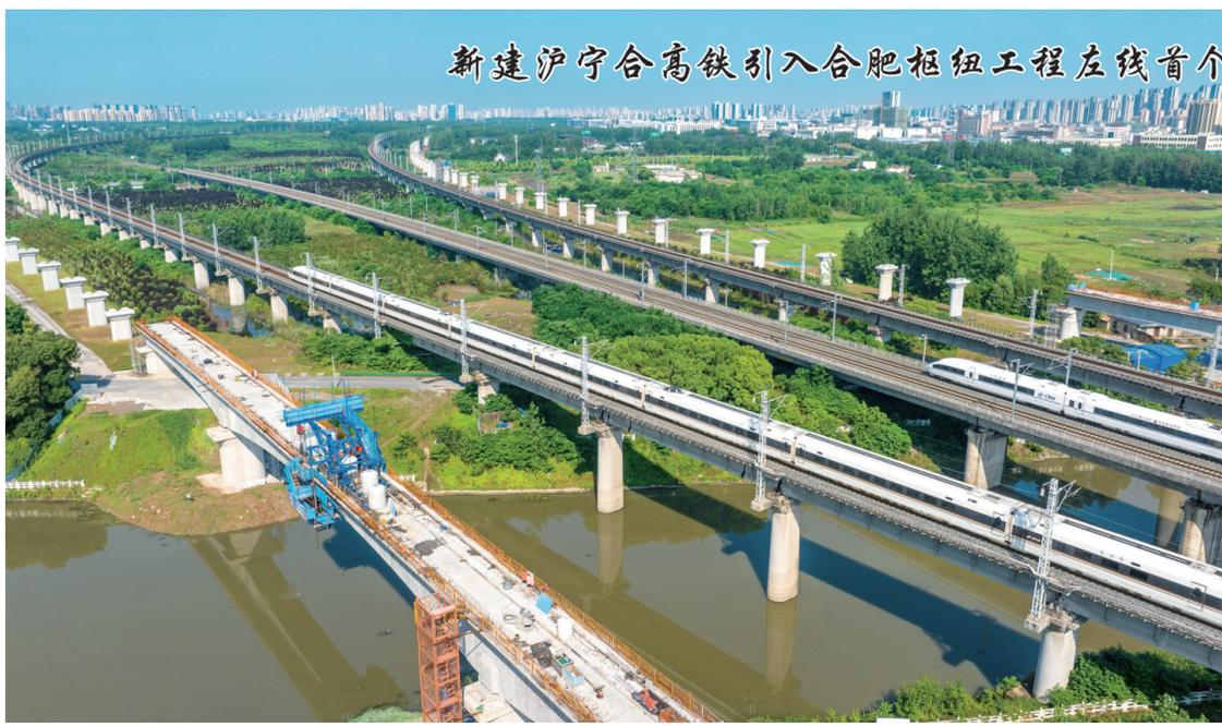
5月28日,由中铁四局承建的新建上海至南京至合肥高速铁路引入合肥枢纽工程跨店埠河特大桥左线首个连续梁顺利合龙,为后续施工奠定基础。
