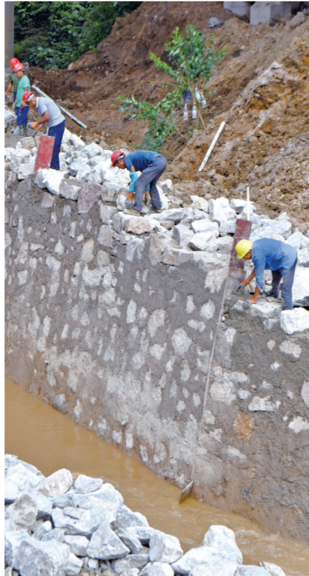
工人正在砌筑堤防
