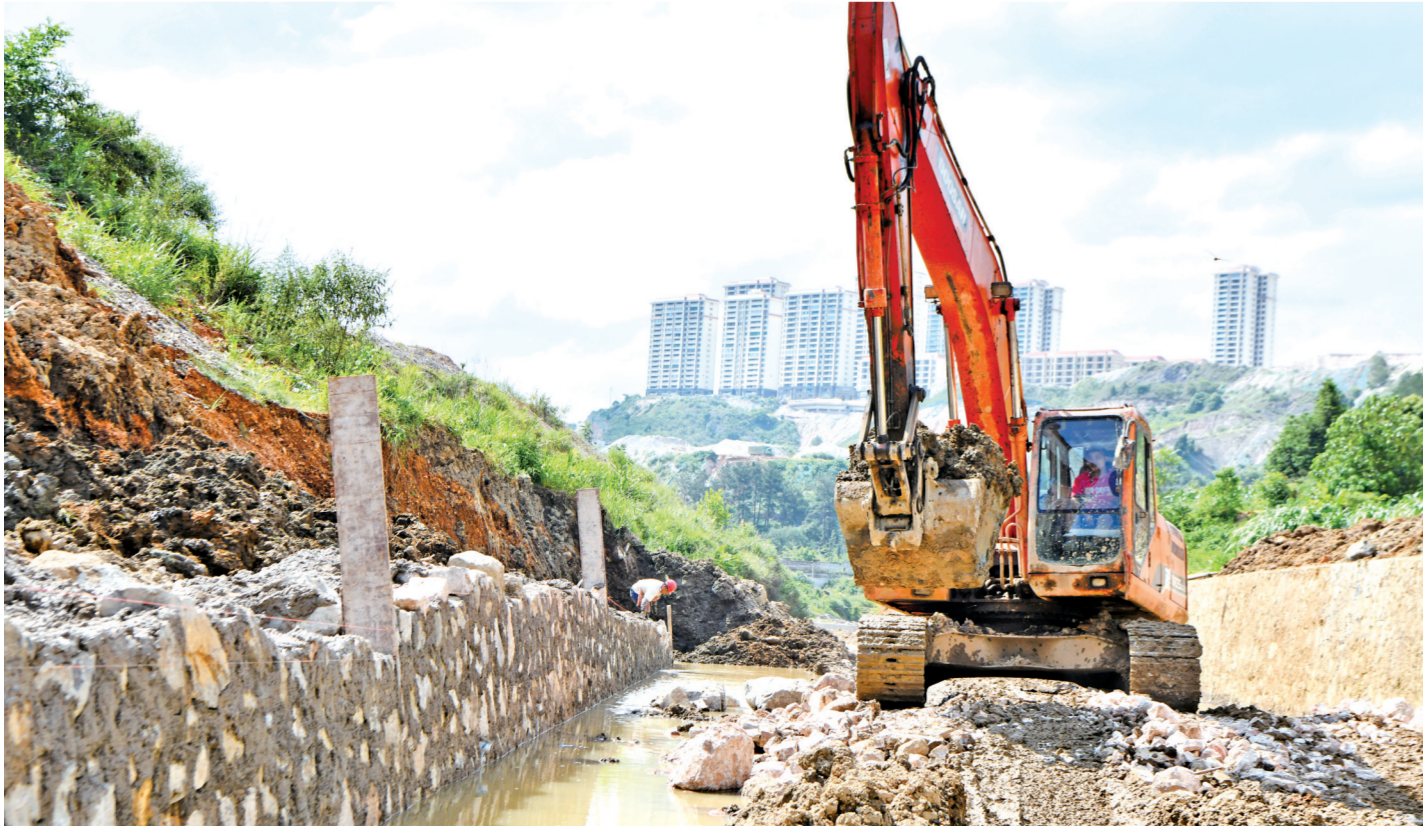
翁牙河山洪沟治理项目——柿花寨段施工现场
