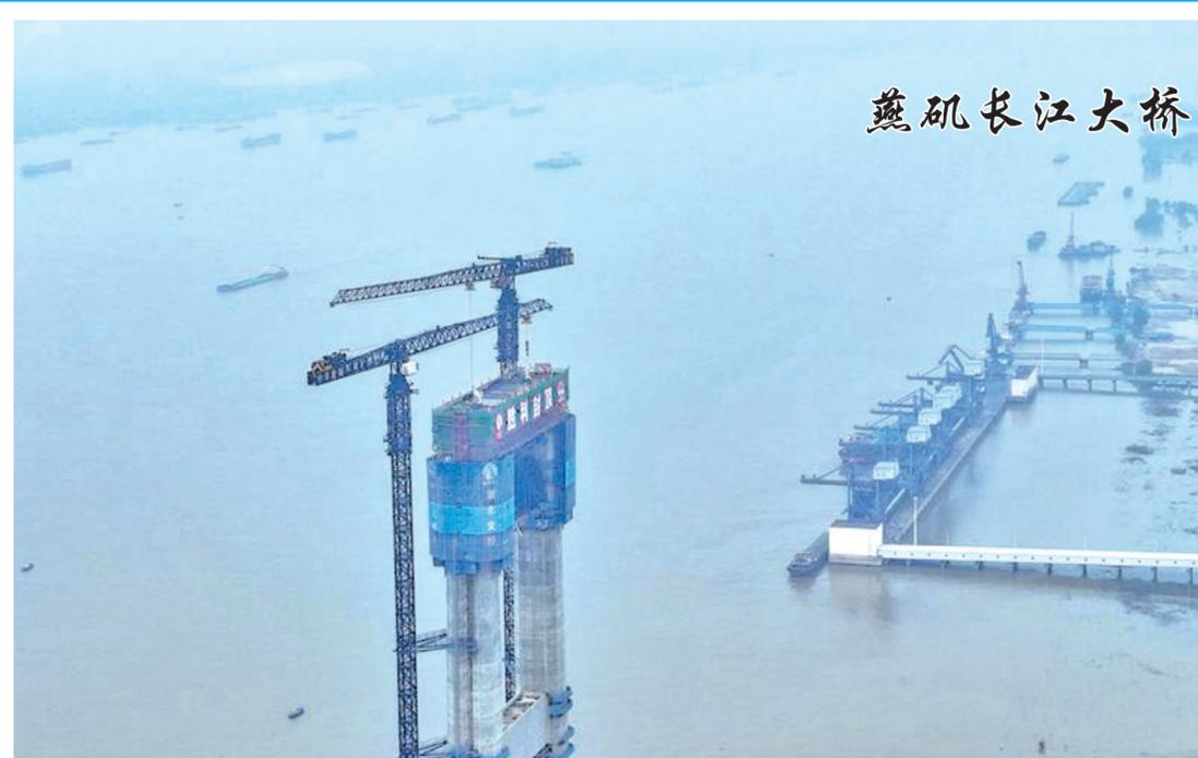
7月14日,由湖北交投投资、中铁大桥局承建的燕矶长江大桥主塔全部封顶。大桥采用双塔单跨设计并一跨过江,主跨1860米。作为鄂州国际物流核心枢纽的综合配套工程,燕矶长江大桥是鄂东空铁、空陆联运立体交通运输体系的重要过江通道,也是推动黄冈、鄂州、黄石三市跨江联动开发,促进三市一体化发展的关键工程。
