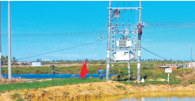
更换低压出线及线路高压绝缘子
