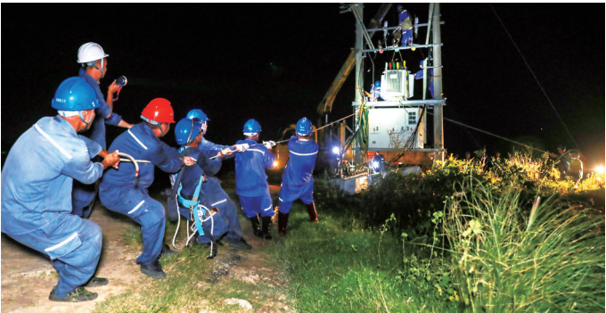
安装新变压器
