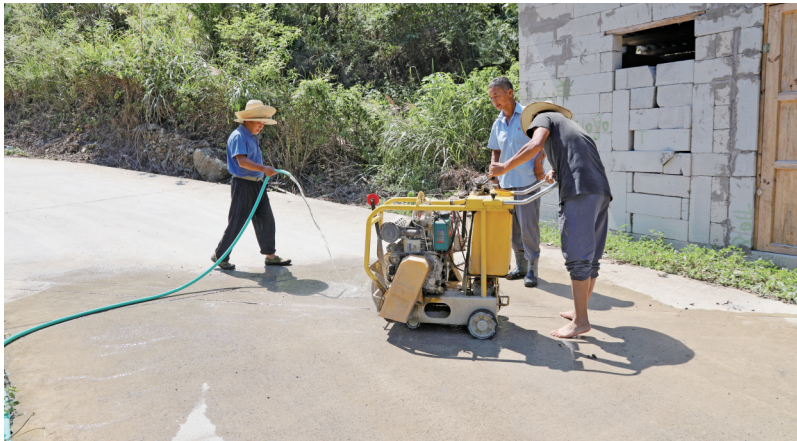
图为黄古村正在进行“水改”及排污系统整治工程 (通讯员 杨健 摄)
