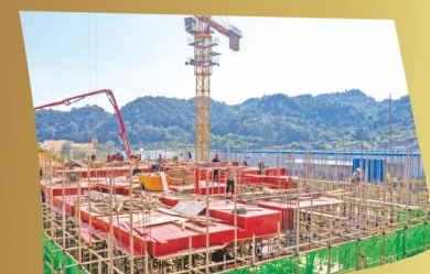
从江县2024年帮扶车间建设项目工地。(通讯员 吴德军 摄)
