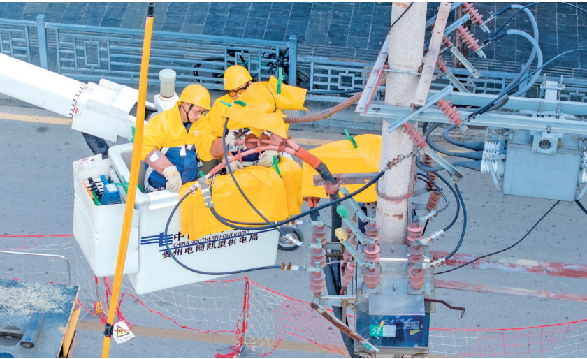
图为工作人员正在进行不停电作业带电检修
