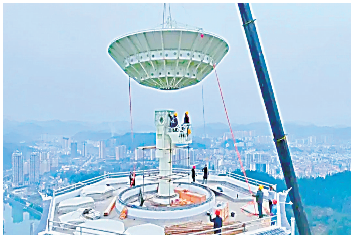
黔东南首部S波段双偏振多普勒天气雷达在三穗完成吊装
