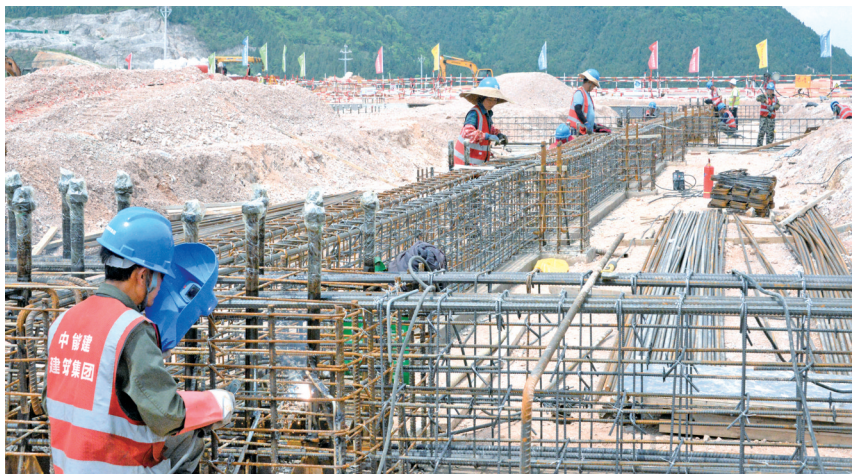
图为项目施工现场
