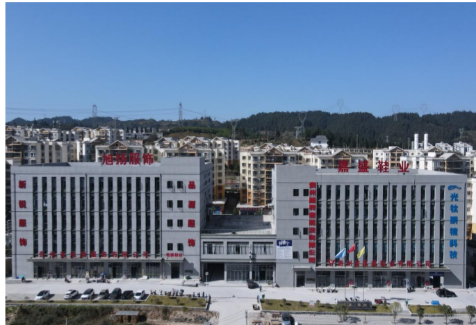
黎平县千凉亭社区的帮扶车间厂房
