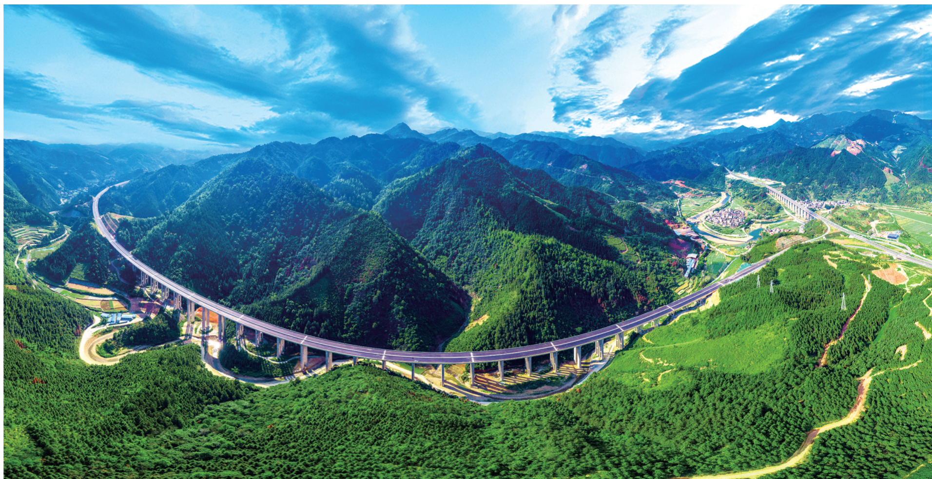
雷山至榕江高速公路华兰溪特大桥 (雷榕项目公司 供图)
