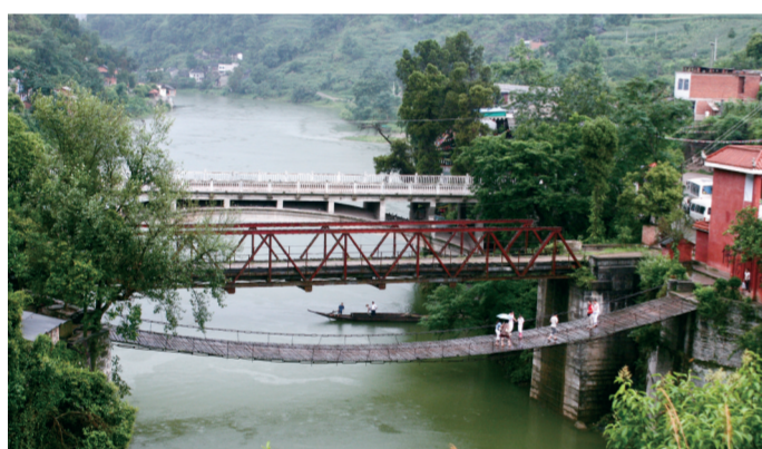
黄平县重安三朝桥
