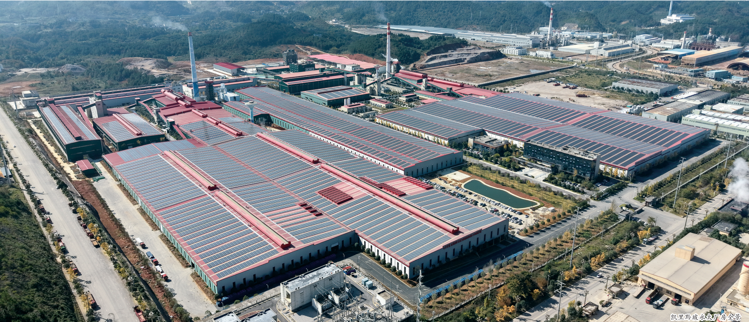
凯里黔玻永太厂房全景
