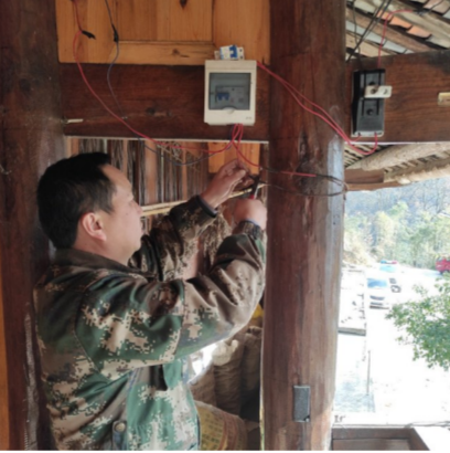
余晓英的丈夫李洪升帮助邻居检修电路
