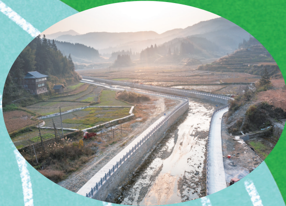
五号溪(龙江段)山洪沟治理工程
