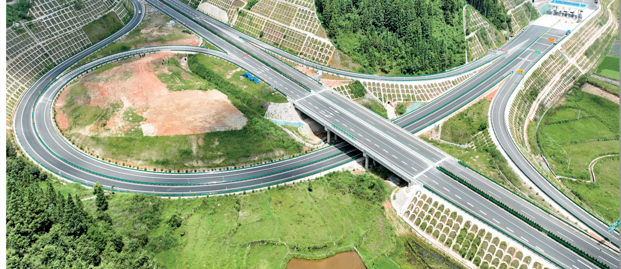
黎平新建公路(通讯员 吴光耀摄)
