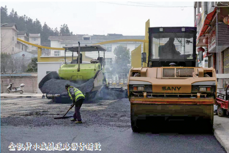
金凯村小城镇道路沥青铺设
