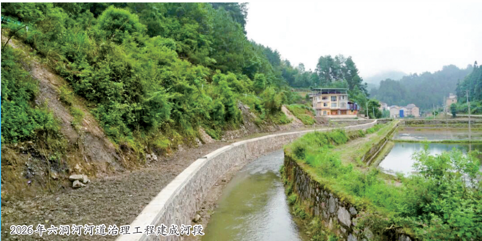
2026年六洞河河道治理工程建成河段
