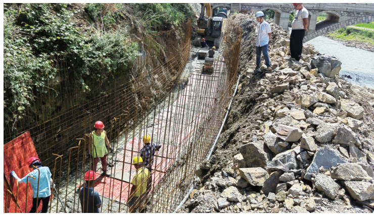
2023年，三穗县水库输水管网工程——沉砂池施工建设
