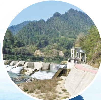
木良水库除险加固工程
