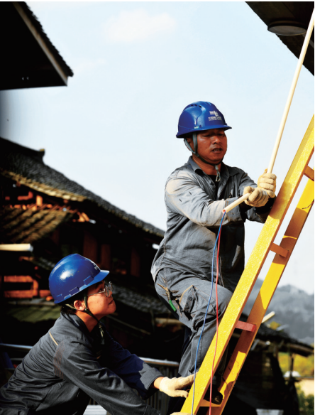
消防电改项目施工
