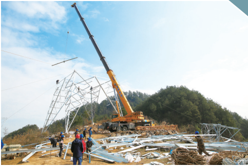
防冰改造工程施工现场
