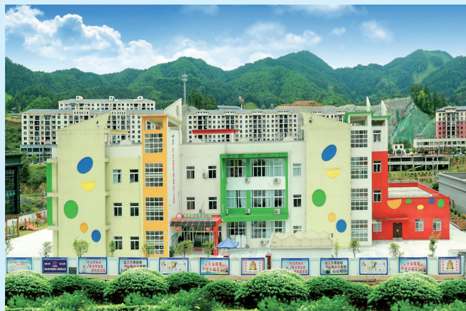
由杭州市富阳区援建的锦屏县示范幼儿园于2019年8月建成投入使用
