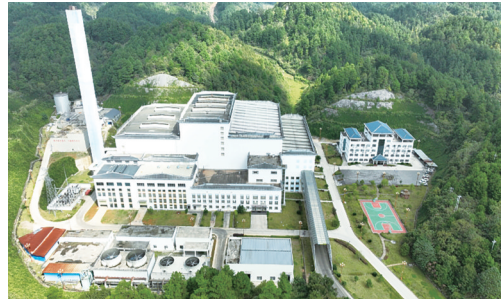
凯里市城市生活垃圾焚烧发电项目
