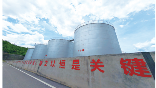
州粮油储备中心1万吨食用油储备罐区
