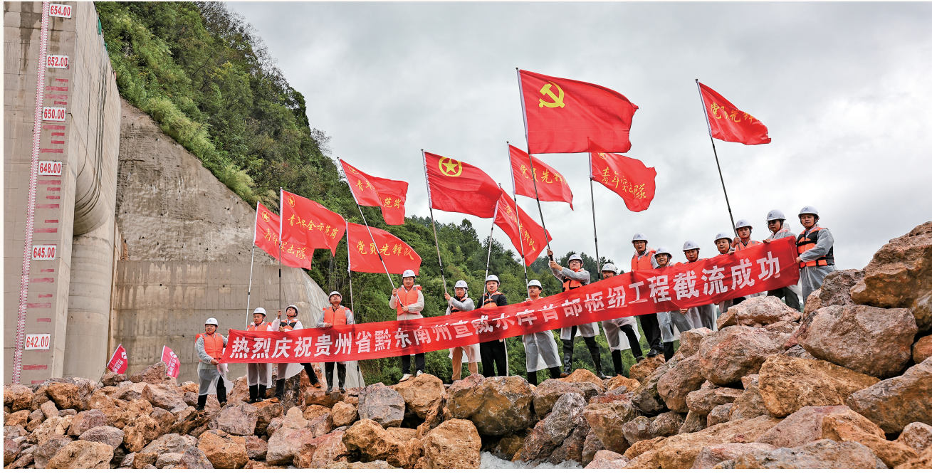
宣威水库截流成功 (黔东南州融媒体中心记者 姚志华 摄)
