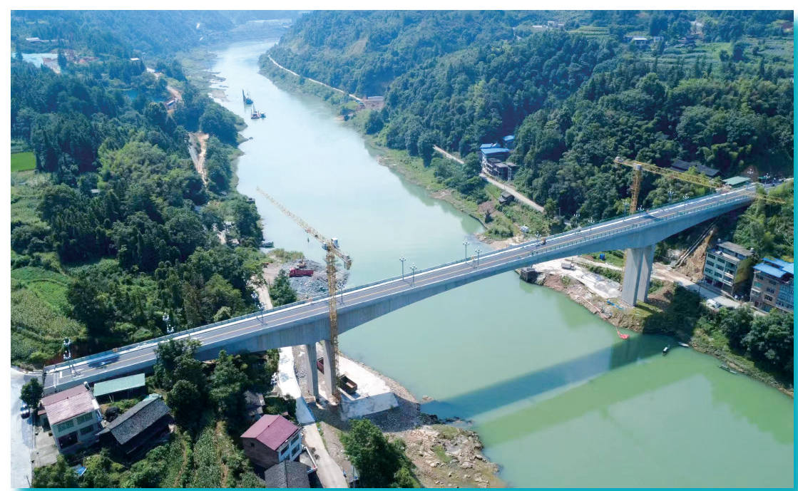
利用移民后扶资金建成的天柱县江东大桥,让两岸移民群众出行更加安全便捷
