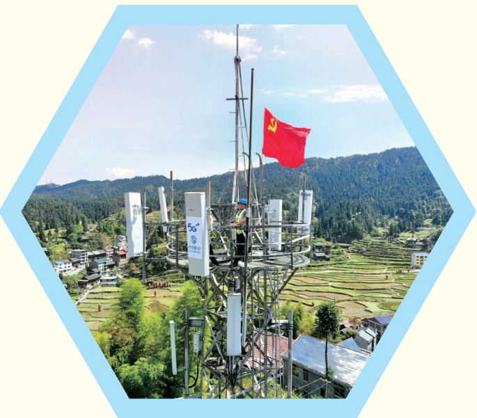
通信基础设施建设
